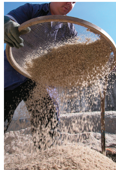
Trabalhador peneirando areia. Com essa técnica, é possível eliminar grãos grandes e obter areia mais fina e homogênea.
